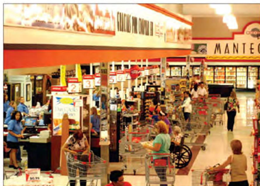
■ El nuevo Econo Vega Baja Supermarket en Arecibo cuenta con 15 terminales de registro de último modelo instaladas por ISE Corp., Miami, FL.
